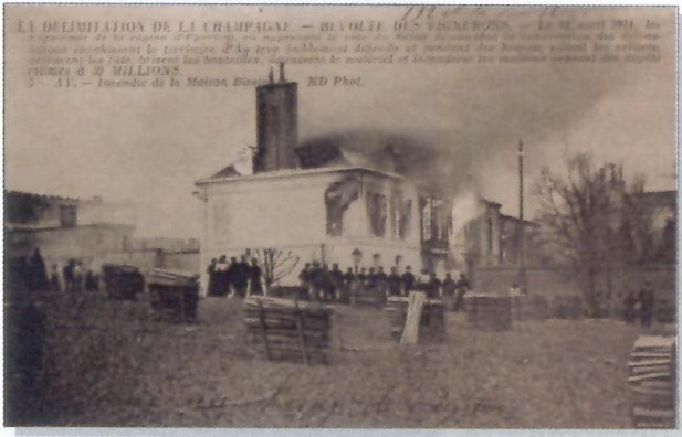
La Maison Bissinger en feu à Ay.
